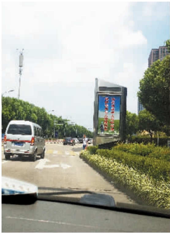
董山中路口,广告牌挡住了驾驶员的视线。
