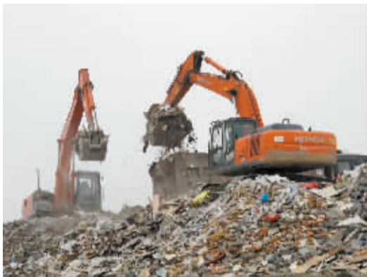
江东仇毕一拆迁工地尘土满天飞。
