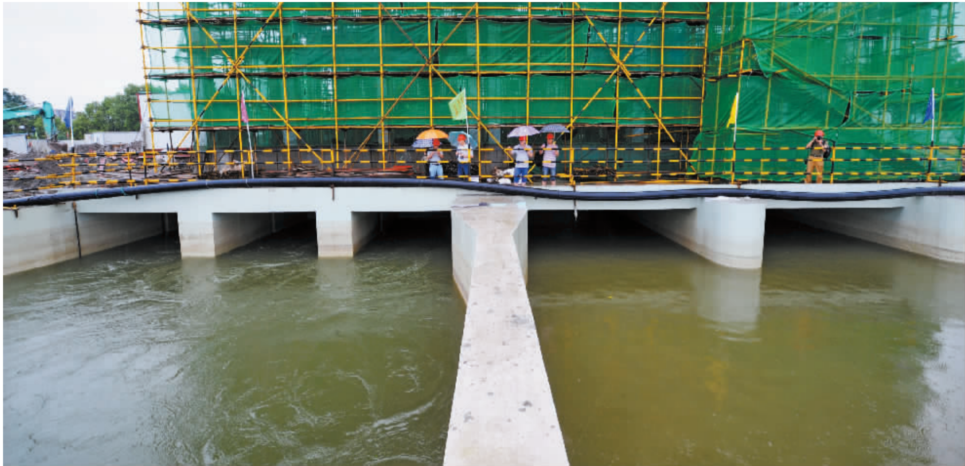
昨天下午,保丰碶闸站首次启用强排。不到两个小时,城区北斗河水位从超过警戒水位的1.59米降到了警戒水位下的1.47米。 记者 龚国荣 摄
