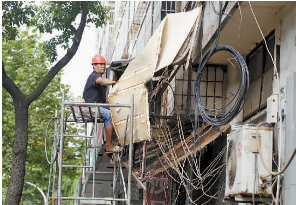
工人正在拆除坍塌下来的招牌。 记者 许天长 摄
