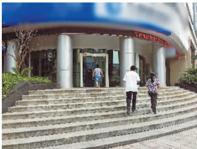
某银行门口台阶旁未设无障碍通道。
