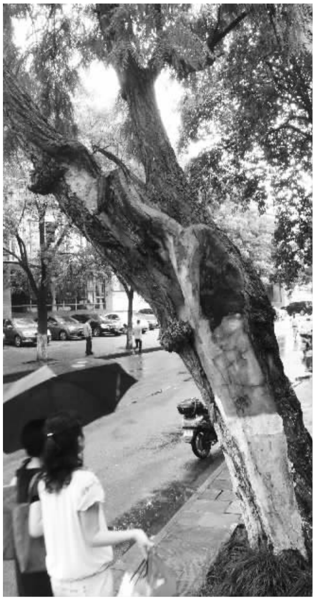
偃月街上,一株树龄300多年的古树由于病虫害影响,树身中间形成空洞,有关部门用水泥填补。记者 龚国荣 摄
