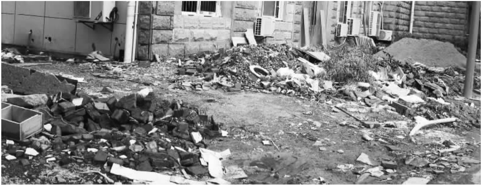
新河路上被占据的人行道。
