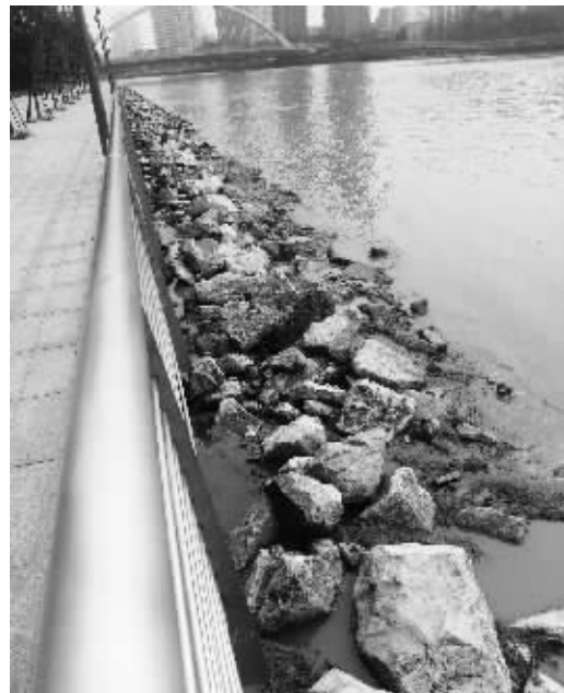
濠河公园旁的抛石护堤现场
