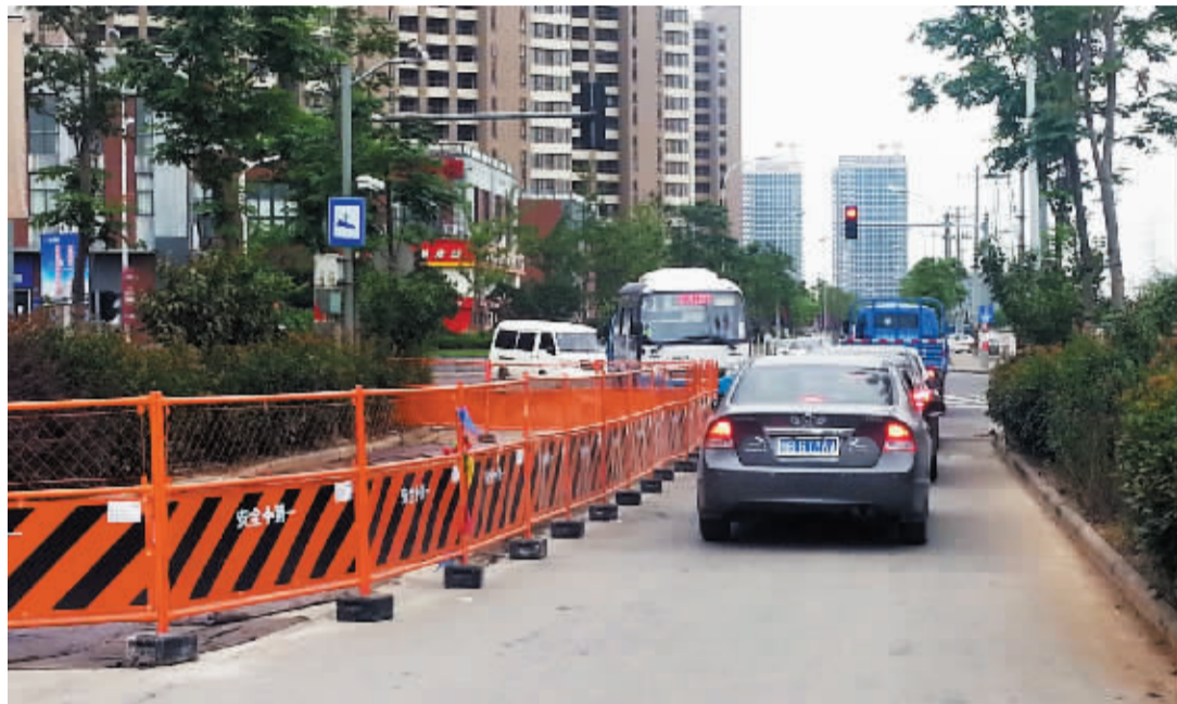
施工围挡占了半幅路面。
