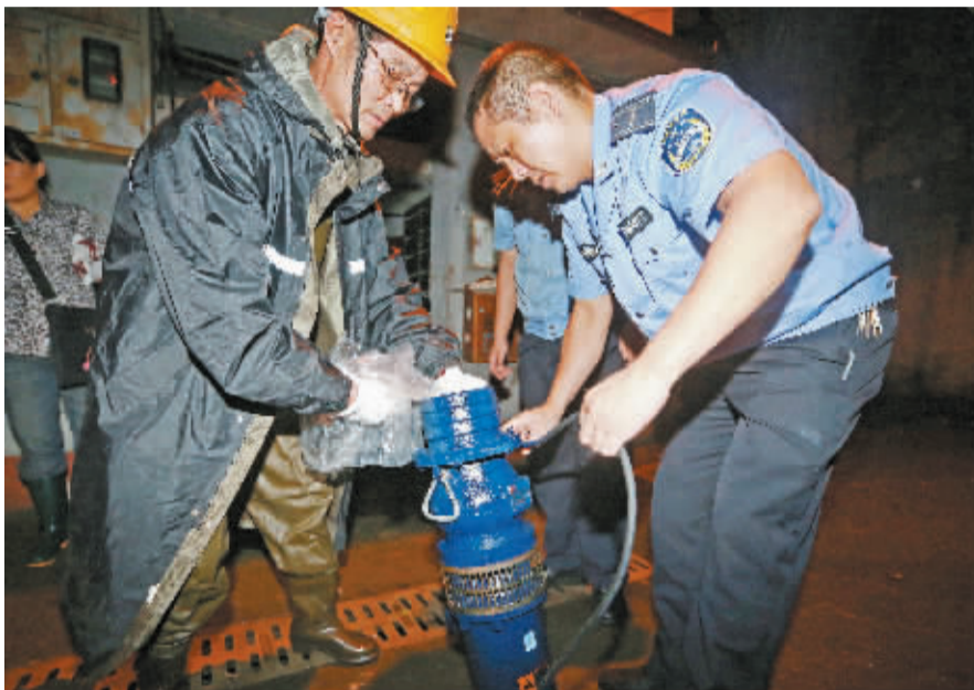
昨天傍晚,江东区给每个易积水小区紧急调集抽水泵。图为来自城管、社区的工作人员在周宿渡社区安装并调试抽水泵。
