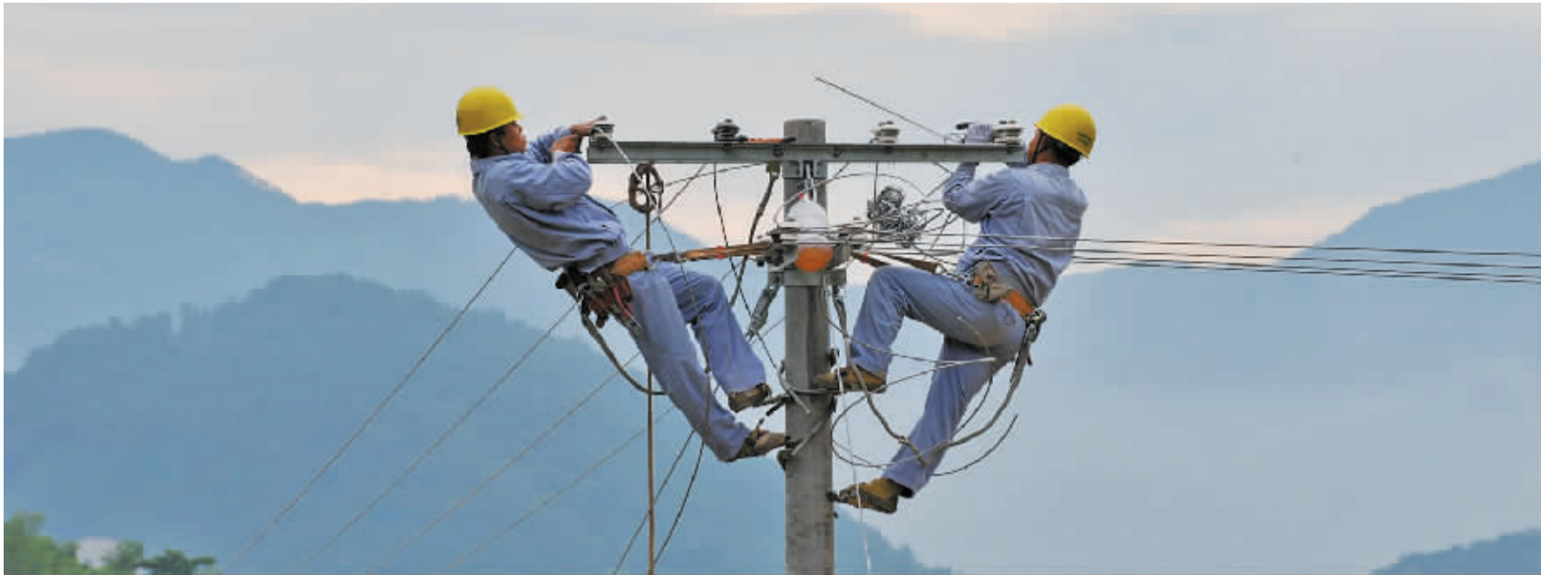
余姚梁弄供电所员工起早摸黑建设改造山区电网。孙晔峰 摄
