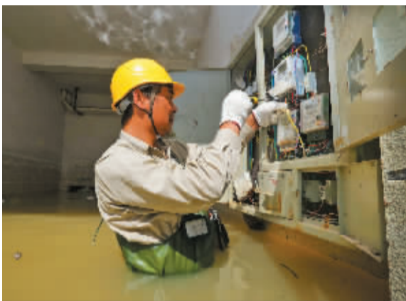
工作人员在地下车库通道对电气设备进行维修。
