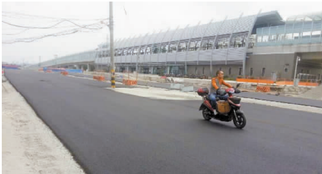
地铁站正门口的坑洼路已浇上沥青,即将完工。记者 沈之莹 摄
