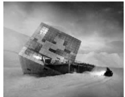
捷克设计公司Atelier 8000近日在一场比赛中设计了一座完美适应特殊山地地形的立方体酒店。酒店以立方体的一个角为中心支撑，旋转一定的角度。酒店的支撑框架由铝制材料、玻璃和太阳能电池板构成(上图)。
