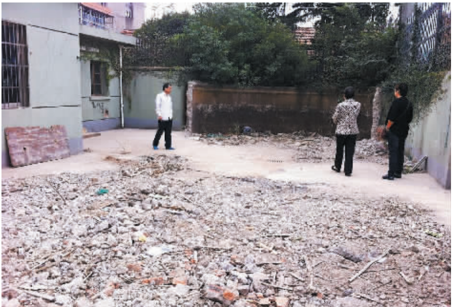
水塔拆除后新增的空地。 通讯员 张立 摄
