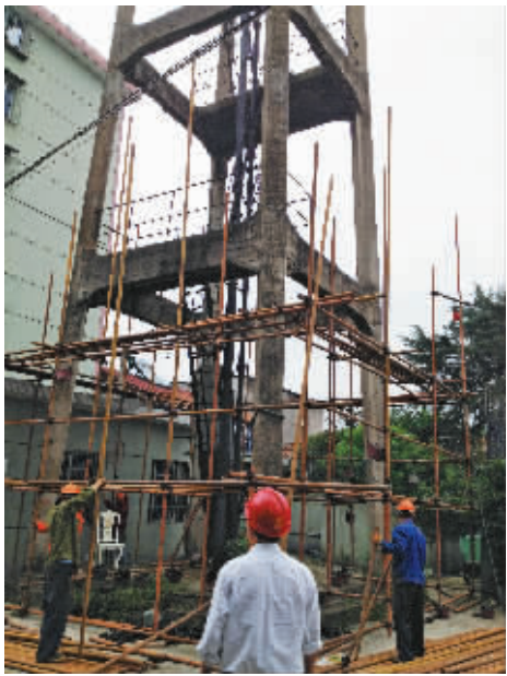
小区水塔被拆。
