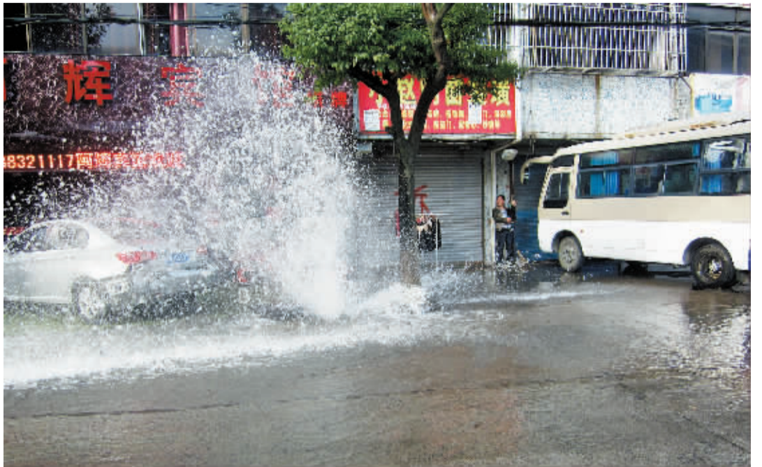
消火栓受损后水溅如注。 交警供图
