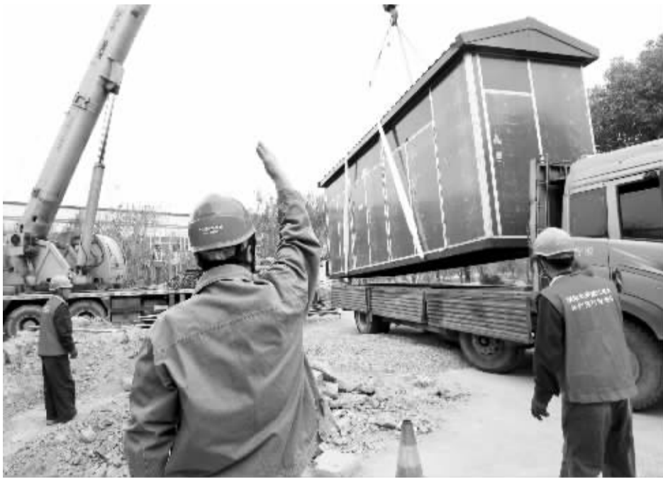
鄞州供电公司在无轨电车创新128站安装输变电设施。
