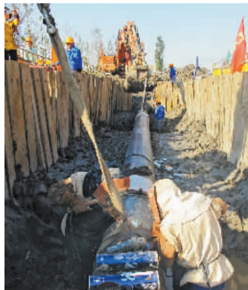
两名焊工在进行最后的焊接。
