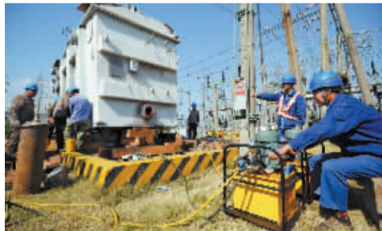
昨天,宁波供电公司工作人员正在进行作业。
