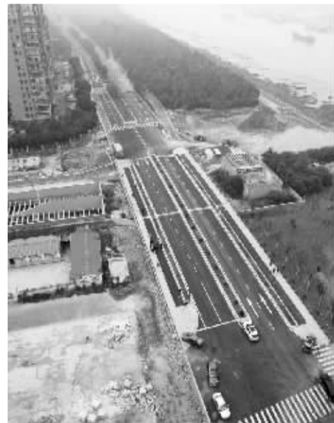
昨天,滨江大道跨常洪隧道沟通工程通过验收并正式通车。 记者 唐严 摄
