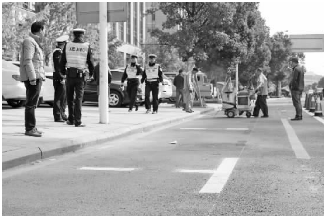
施工人员正在划临时停车位。 图片由下应交警中队提供
