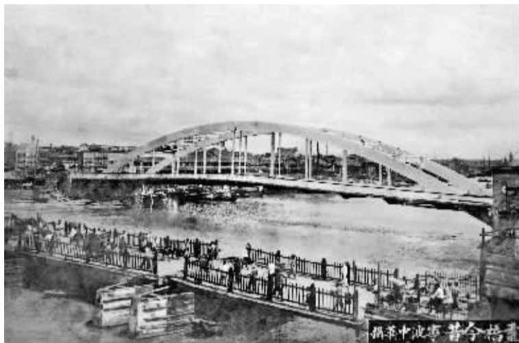
灵桥即将竣工时
