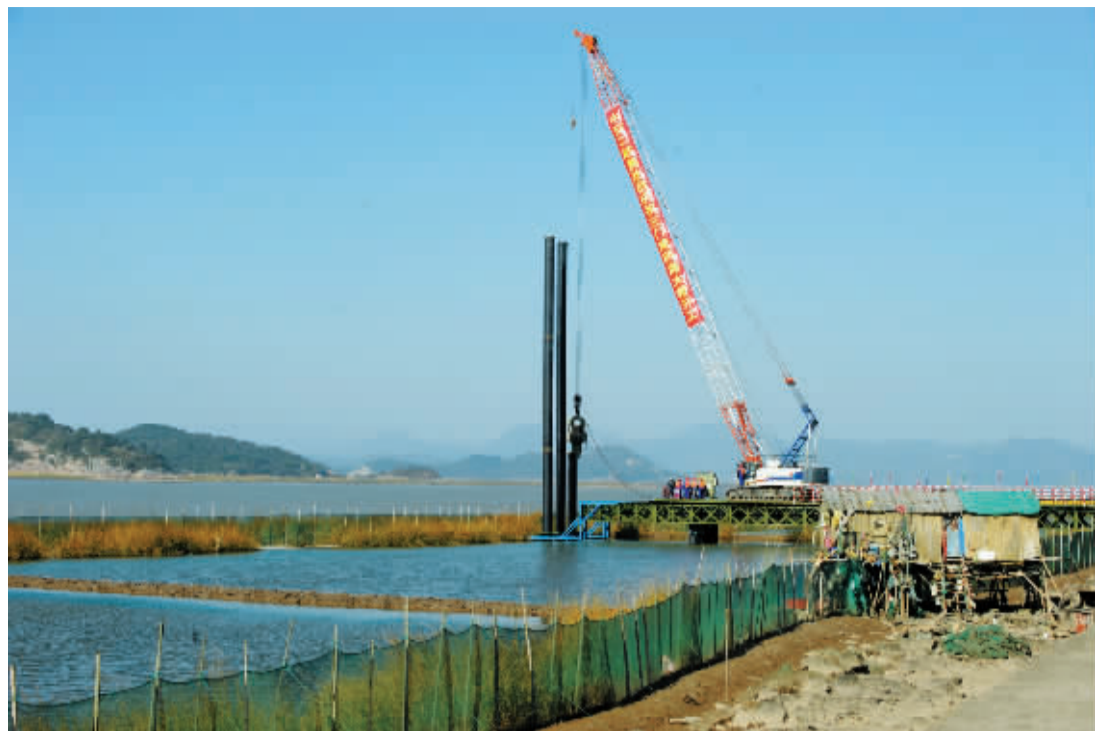
昨天上午,海上栈桥平台三根钢管桩中第一根开始徐徐下沉。
