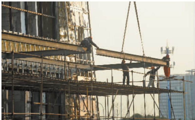
南站交通枢纽施工现场。 记者 龚国荣 摄
