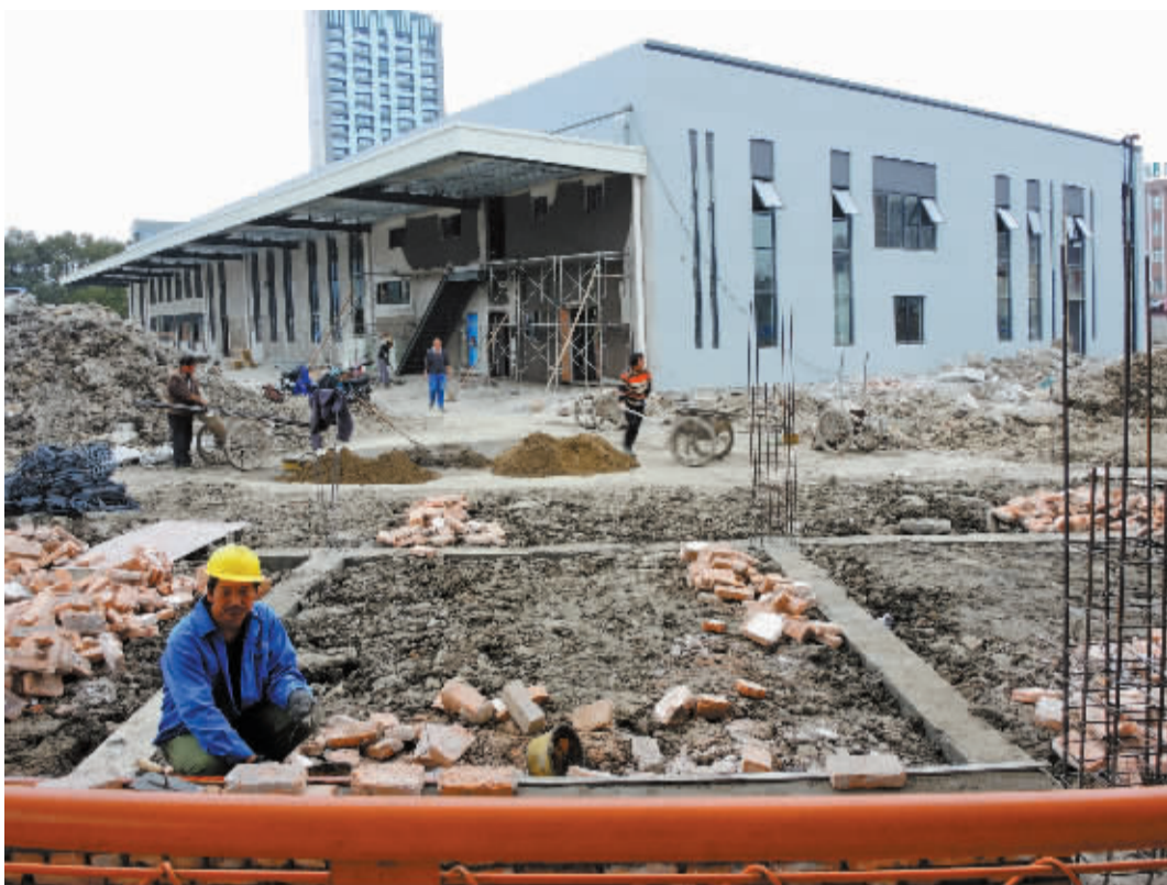
目前正在加紧建设中的新的汽车东站。 记者 龚国荣 摄
