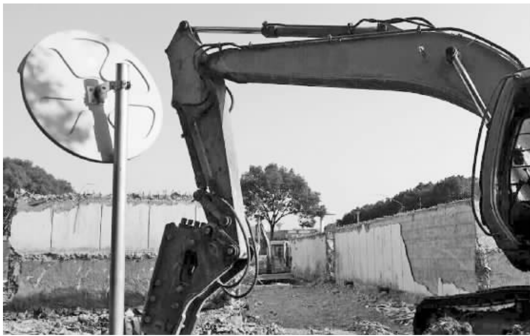
江东水厂开始动工改造。 记者 边城雨 摄
