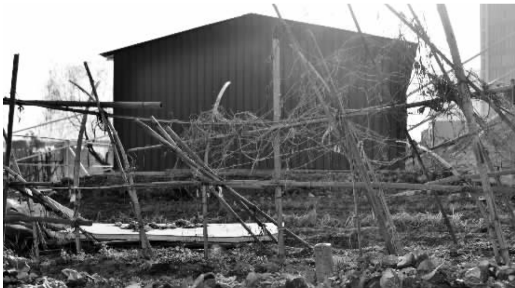
这间铁皮房搭建在燃气管道上。 记者 边城雨 摄
