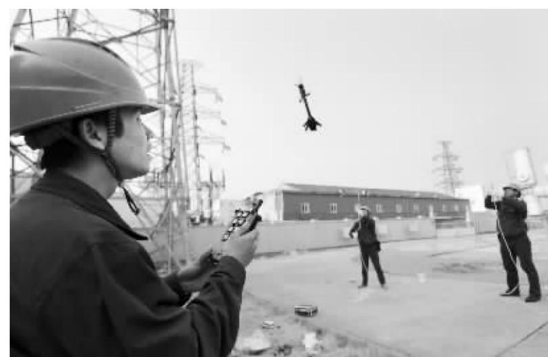
记者昨天从供电部门获悉,一种新的电线除冰装置已经亮相。这种新的装置名为机械振动除冰。操作办法是,首先在地面上组装好破冰器和射绳枪,扣动射绳枪,绳子跨过结冰的线路,一摁按钮,破冰器内空包弹点火燃烧,输电线路上随即产生剧烈振动,供电线路上的冰块纷纷掉落。吴明京 王幕宾
