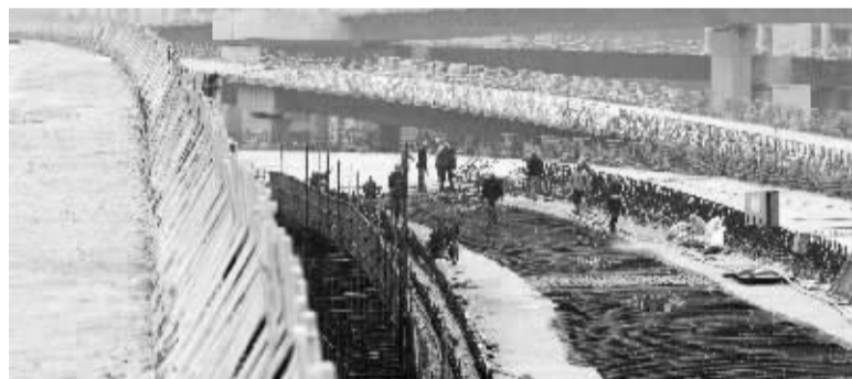
机场快速干道永达路连接线现场工人正在加紧施工。记者 唐严 摄
