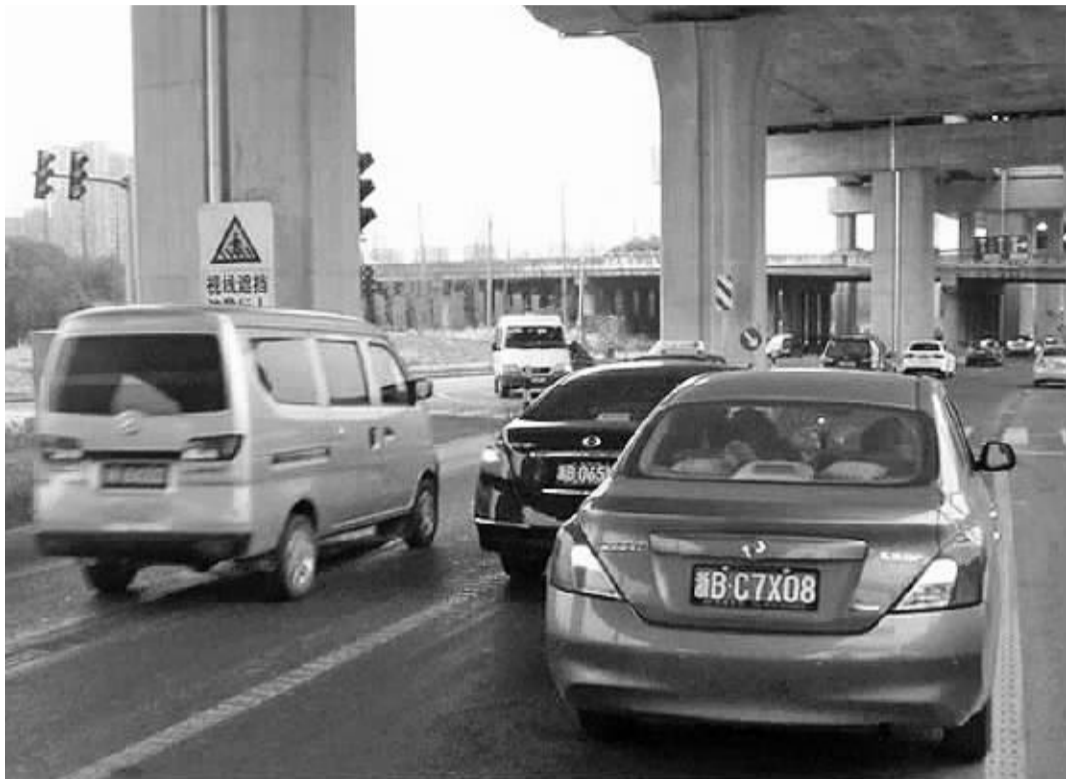
高架水泥柱构成的“桥墩林”。 交警供图
