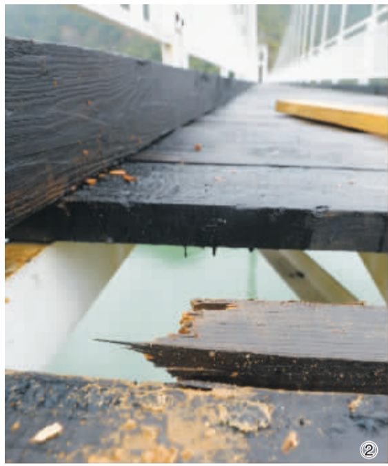
①大桥上已挂出“禁止通行”的警示牌。②桥面已有木板破损,露出空洞。 记者 徐佳伟 摄
