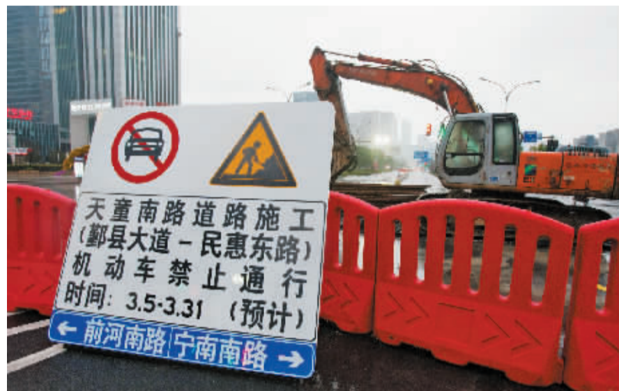
天童南路封道施工,对交通影响很大。 记者 唐严 摄
