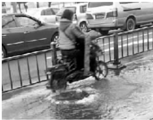
尹江路上一个窨井经常冒污水。 网友供图
