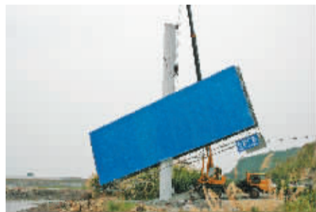
象西线沿线高炮广告牌拆除，参照的是高速公路标准。
