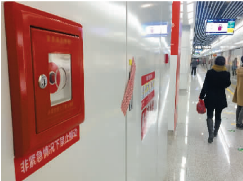
地铁站的紧急停车按钮 记者 许天长 摄
