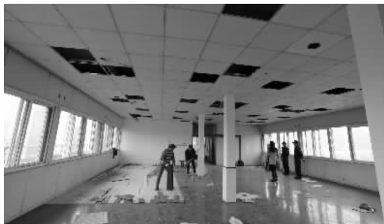
拆违现场。 记者 边城雨 摄
