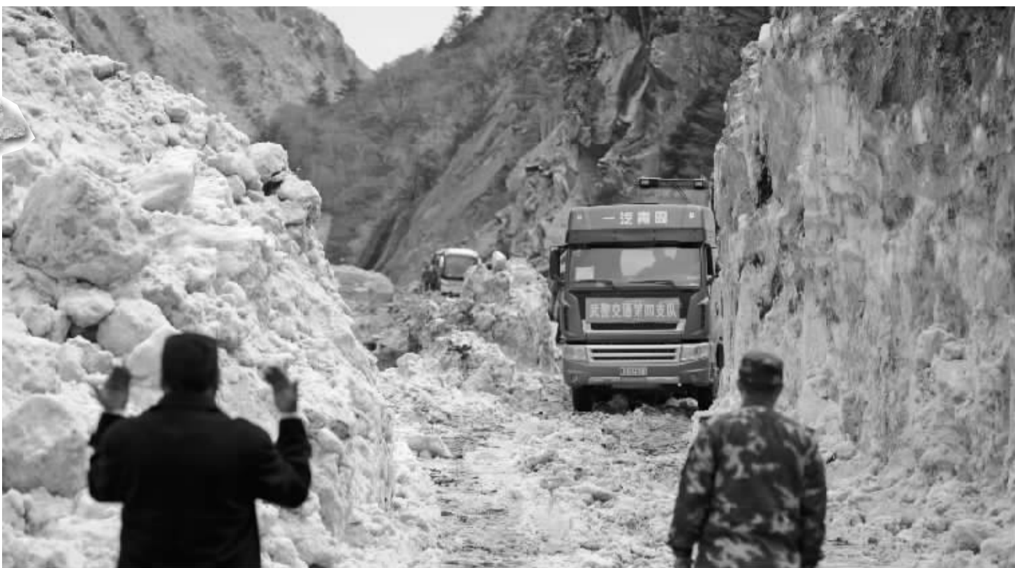
4月27日,武警交通部队全力打通聂拉木县至樟木镇受阻道路。
