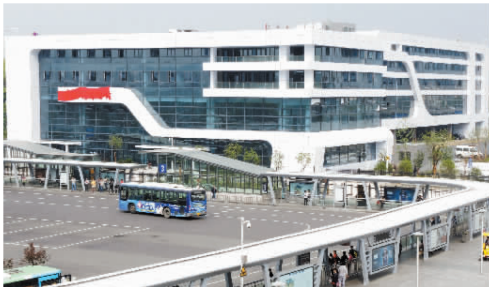
位于铁路宁波站南广场西侧的新汽车南站外景。新汽车南站将于5月7日启用。记者 龚国荣 摄
