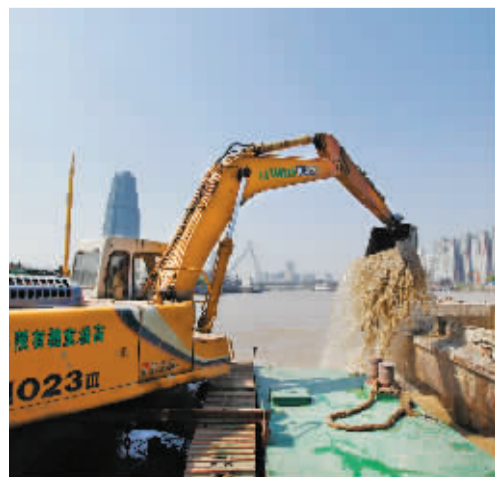
三江清淤工程。记者 许天长 摄
