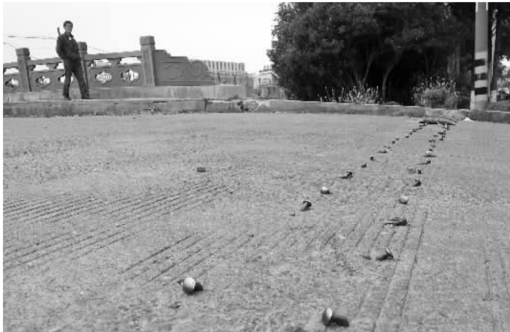
望童路一家木材厂出口处裸露的减速带铁钉。 记者 马涛 摄
