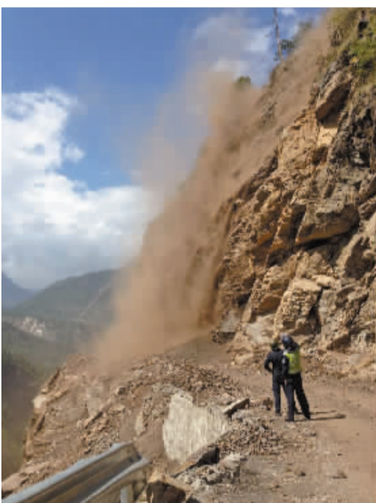
12日,吉隆镇通往吉隆口岸的路段发生塌方(手机拍摄)。
