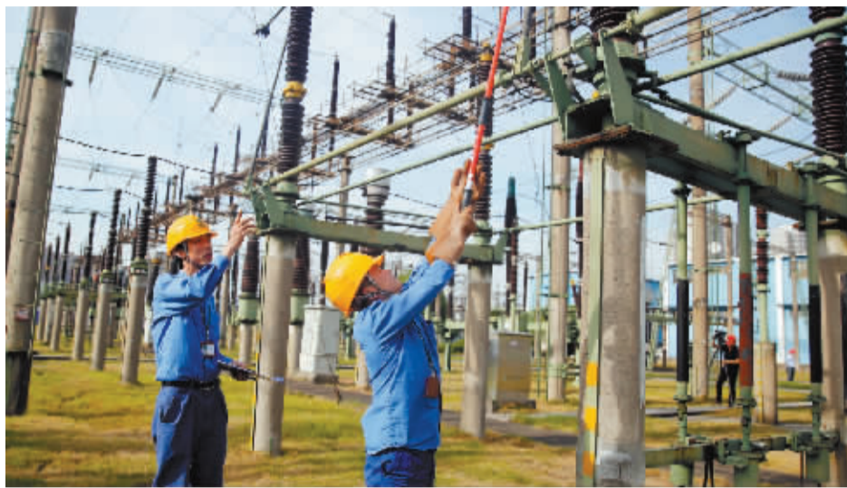
工作人员正在对宁西变电站设备验电。王幕宾 摄
