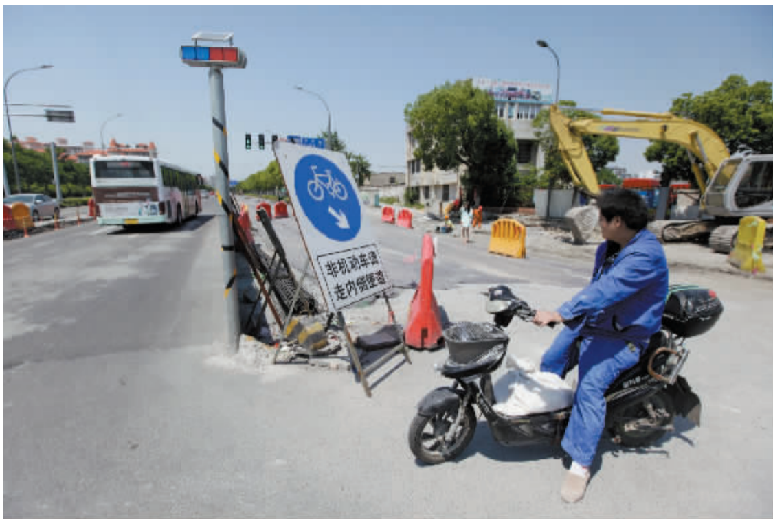
正在施工的青林渡路上，虽然有指示牌提醒，但还是有人因找不到非机动车道入口而感到迷茫。 记者 许天长 摄
