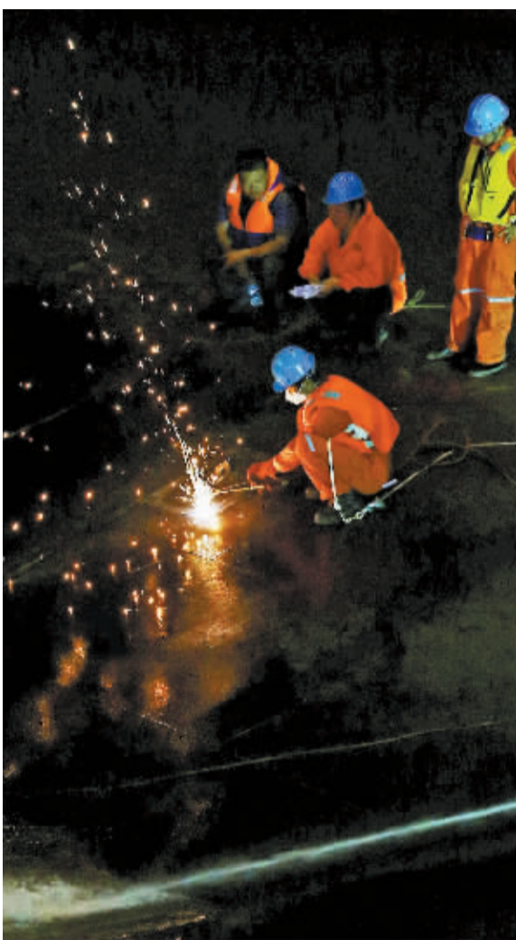
3日晚,救援人员对“东方之星”底部进行切割作业。 新华社发
