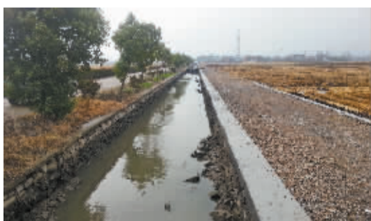
三七市小农水—渠道
