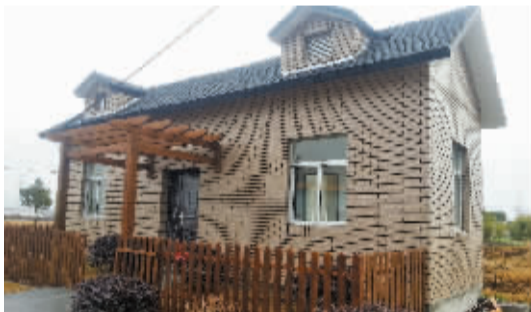
余姚三七市小农水—泵站
