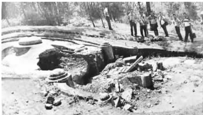
刘永福墓地被盗挖,墓碑区域发生坍塌。
