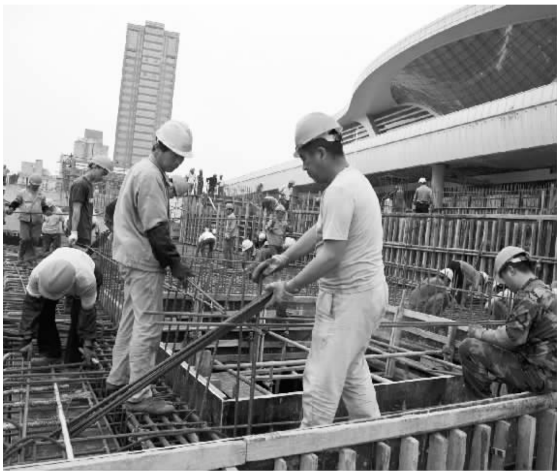
铁路宁波站北广场主体结构昨天进入最后工序。 记者 王勇 摄
