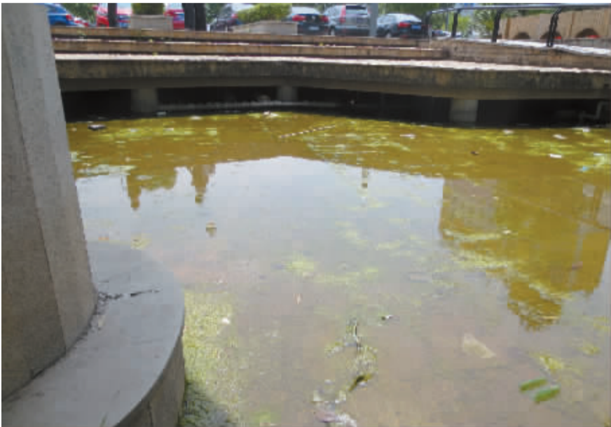
整治前水底淤积泥土，水面漂浮垃圾。
