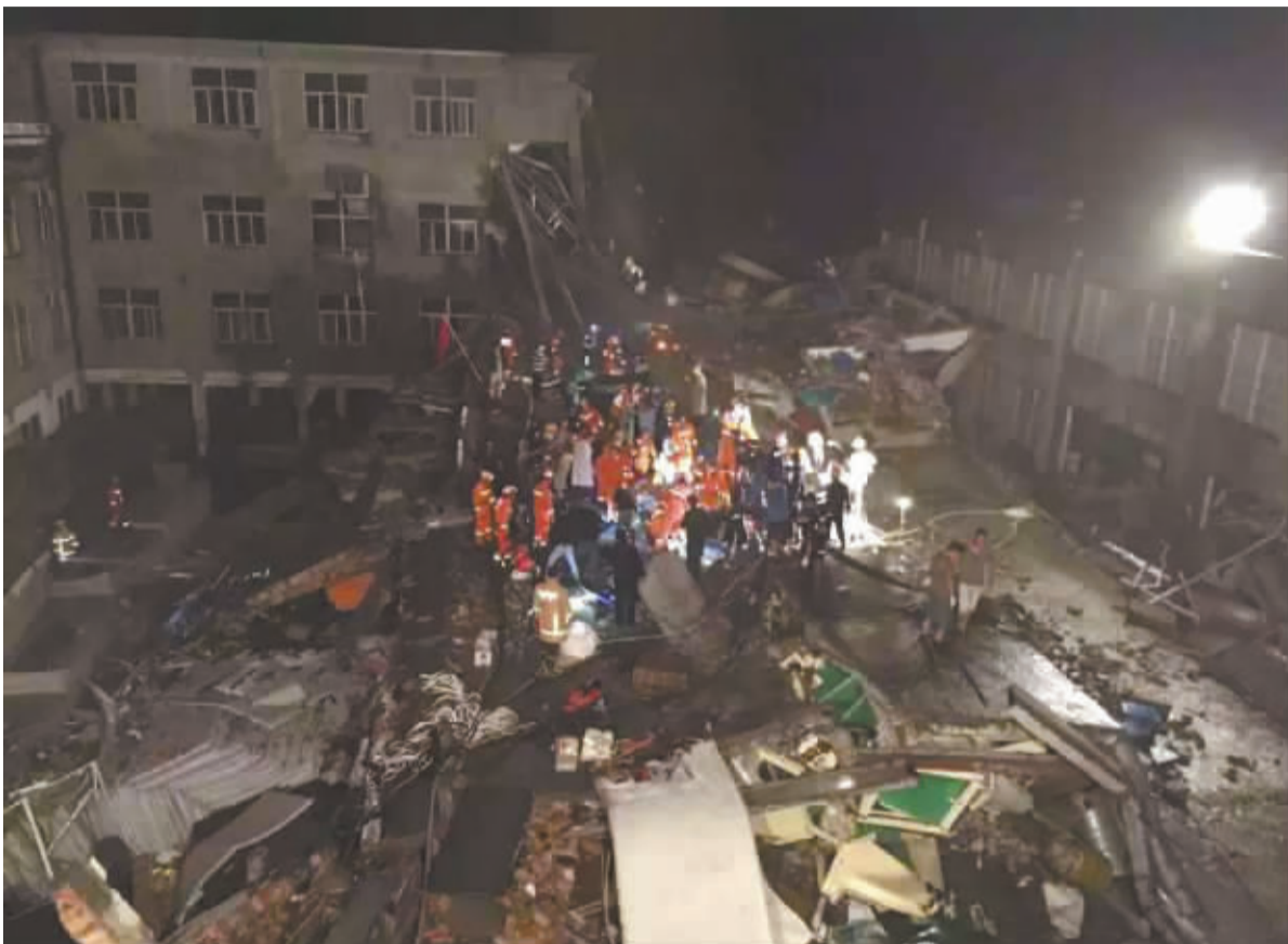
7月4日,救援人员在温岭市大溪镇佛陇捷宇鞋厂房屋倒塌事故现场救援。 新华社发
