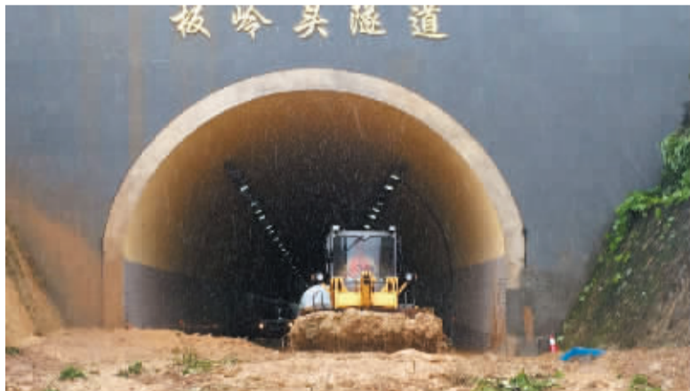
正在抢通隧道。 通讯员 董俊 摄
