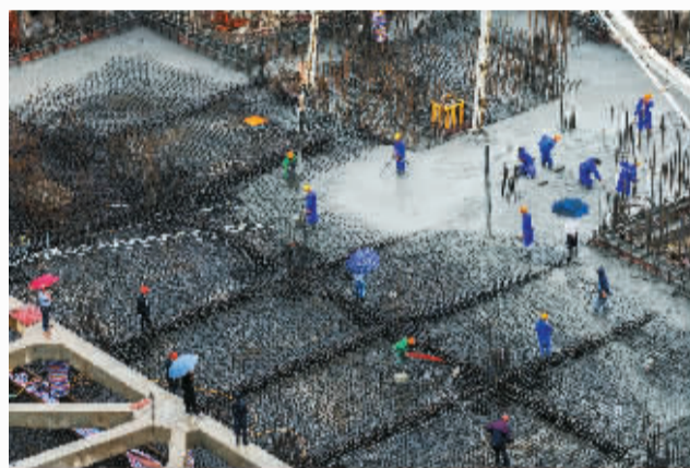
《施工现场》钱樱子
